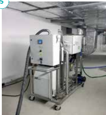
MOBILNY SYSTEM DEZYNFEKCJI OZONEM W PODBASENIU W TRAKCIE DZIAŁAŃ NAPRAWCZYCH
