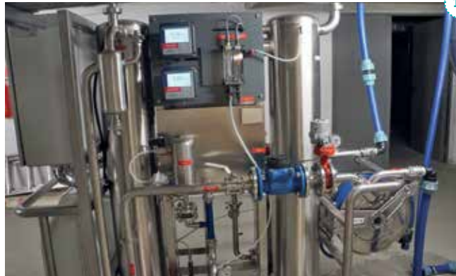
WIDOK URZĄDZENIA SPiD W TRAKCIE PRACY
